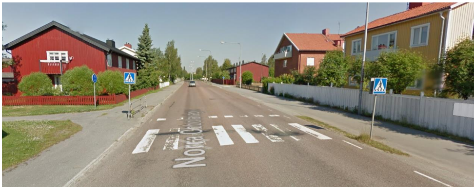
Figur 8-20 Övergångsställe med anslutande gång- och cykelbana norr om Östtegs skola
