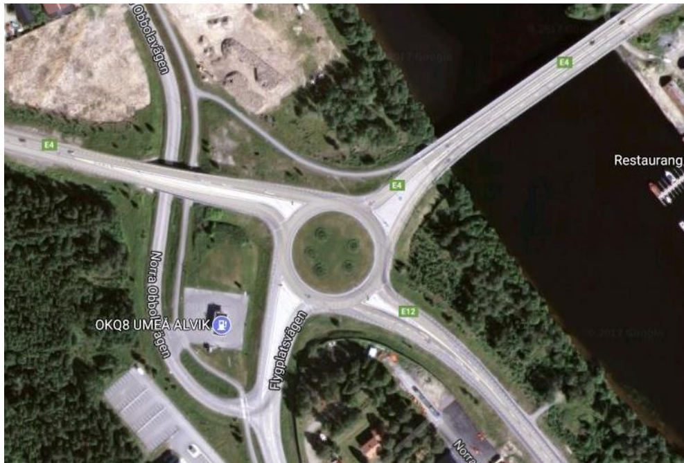
Figur 0-5 Cirkulationsplats som sammankopplar Flygplatsvägen, E4 och E12.
