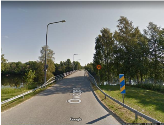
Figur 6-5 Nuvarande bro till Ön är smal och har svårt att rymma gång, cykel och busstrafik med önskvärd standard. (Bild: Google maps)
