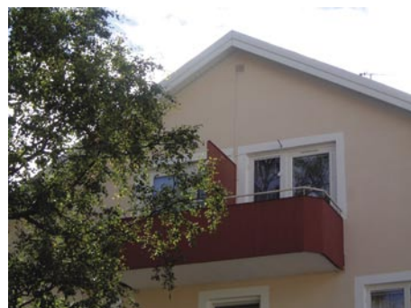
Många av 40-talets och 50-talets hyreshus byggdes med vindslägenheter på gavlarna. Fasadutformningen anslöt till byggnadens övriga formspråk. Här en delad balkong med tidstypisk finkorrugerad plåt.
