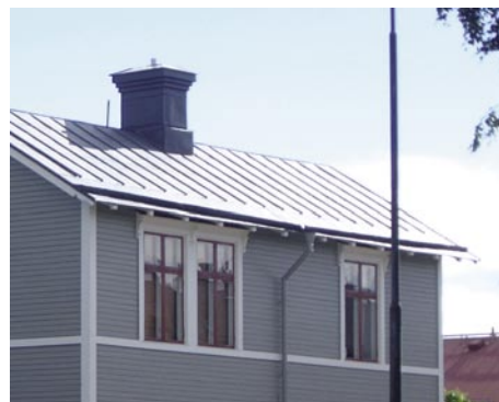
Pricken över i:et på detta sekelskifteshus är det tunna och vackert lagda plåttaket. Observera skorstenens fins plåttäckning och stuprörens tidstypiska skarpa vinklar.
