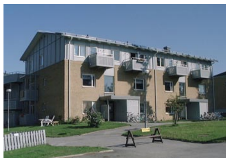
Påbyggnad av 70-talshus på Hyggesvägen 16–17. Den nya våningen samt tillagda balkonger och entrépartier är utförda i lätt träkonstruktion och gråmålade. Tilläggen är urskiljbara. Samtidigt samspelar de på ett fint sätt med den ursprungliga tegelfasaden.
