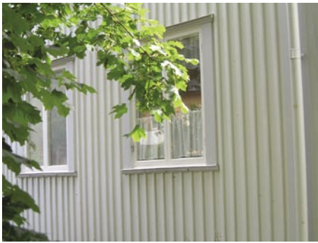
Hemvägen 5. En vacker fasad i originalutförande från 40-talet. Typiskt för tiden är panelen som är spontad, den nätta ribben, fönstrets läge i fasadliv, de tunna profilerade listerna ovan och under fönstren och de breda stående fodren.
