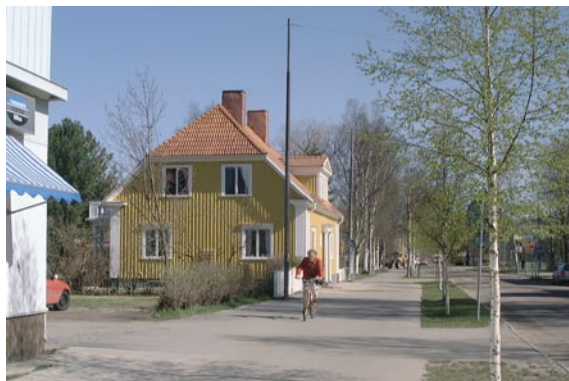
2. Ovanför Hagaplan påminner Östra Kyrkogatans sektion fortfarande om den ursprungliga med körbanan parallell med omgivande kvarterssidor och kantad av allébjörkar.
