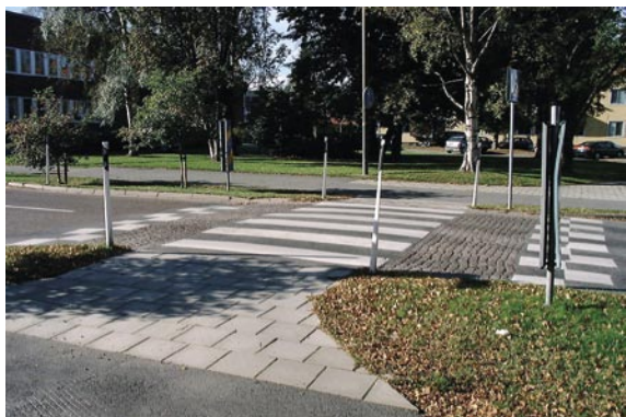
1. I höjd med Hagaplan finns idag detta övergångsställe, fördömligt gestaltat med avsmalnad körbana, förhöjd gångyta, natursten och gräsytor.
