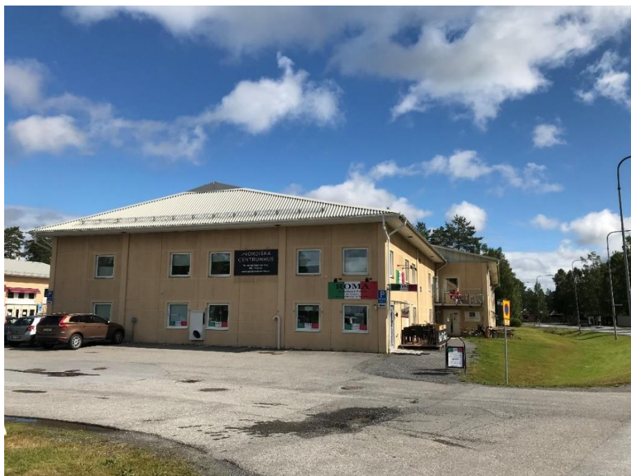
Figur 7. Befintlig byggnad inom planområdet.
