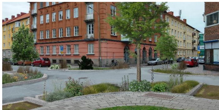
Figur 23. Exempel på nedsänkt stråk med växtlighet. Bilden är tagen vid en korsning i Kristinelund och kompletterad med växtlighet.
